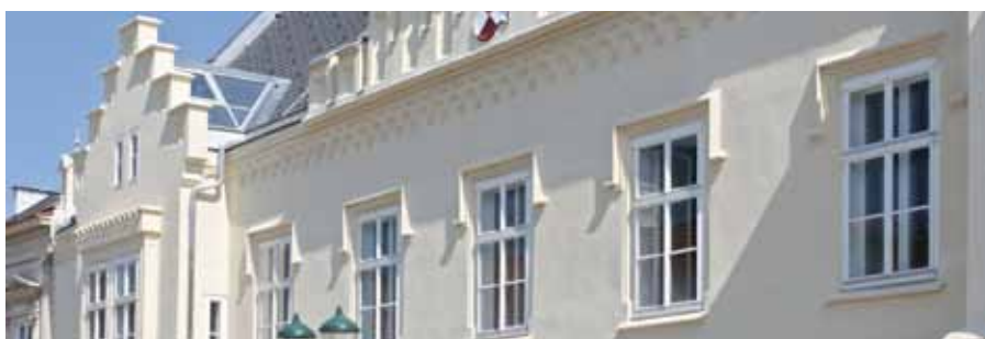
Hotel Central, Perchtoldsdorf, NÖ, RÖFIX Renoplus® s RÖFIX PE 229 SOL SILIKAT
