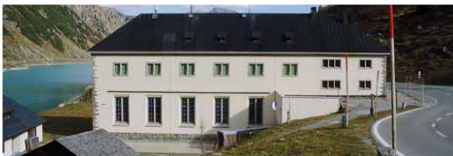
Elektrana Obervermunt, Vlb., 1800 m NV, RÖFIX Renostar® s RÖFIX PE 429 SILOSAN
