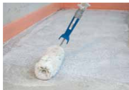
Nanošenje predpremaza
